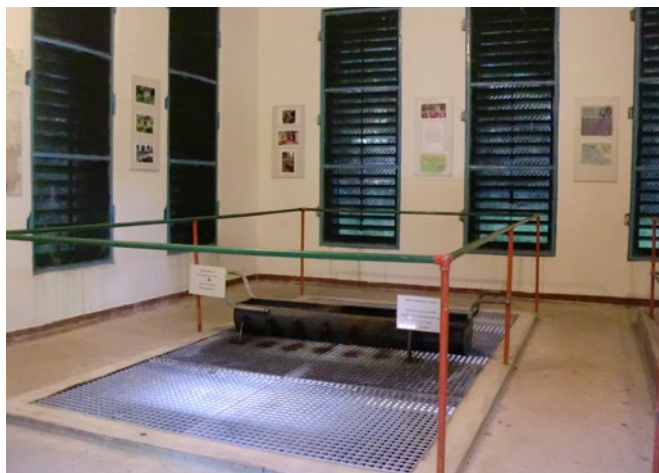
Blick in das Innere des Oberen Wasserhauses
